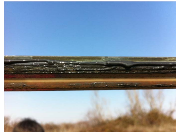
Detalle del cable engrasado con COPLALUBER
