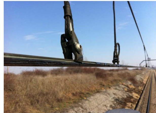
100 Km de Catenaria engrasada, en 2 horas.
