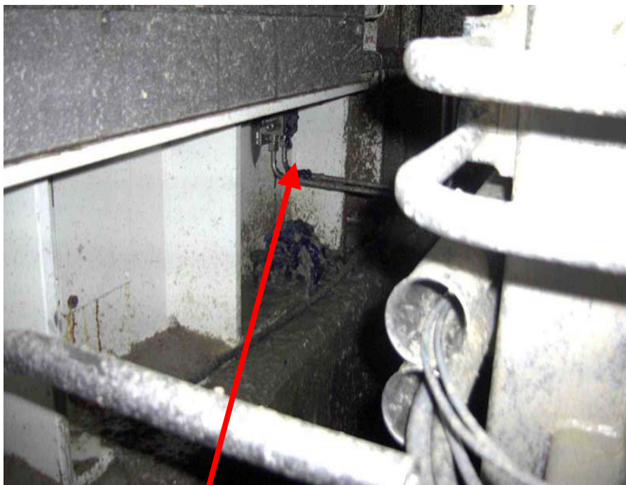
Dosificador de línea doble dispuesto en zona preparación de pastas (Molino astillas)
